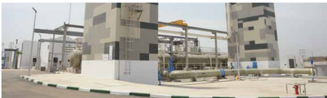
Station Eaucéan - Evacuation des eaux traitées via l'émissaire marin
