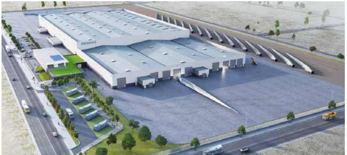
Centre de Formation Usine à pâles Tanger
