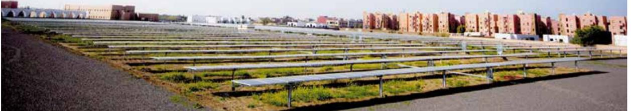
Jet Energy a réalisé une centrale solaire avec une technologie de tracking mono-axe, une première au Maroc. Contrairement à l'installation sur des structures fixes, l'utilisation de trackers permet d'améliorer le rendement d'au moins 25%.
