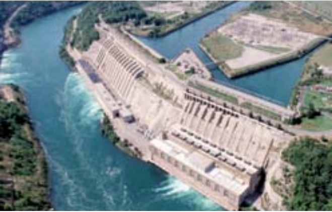
Figure 3 : Photo aérienne du complexe 'Sir Adam Beck' au Canada utilisant la technique STEP comme solution de stockage' (Source photo : Creative Commons Attribution 2.0 via Wikimedia Commons)
