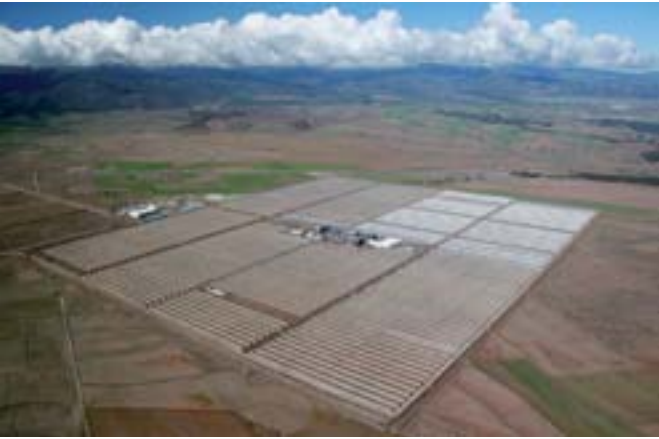
Figure 2 : Photo du site d'installation Andasol en Espagne avec la technique 'Sels fondus' comme solution de stockage' (Source photo : «12-05-08 AS1» by BSMPS)
